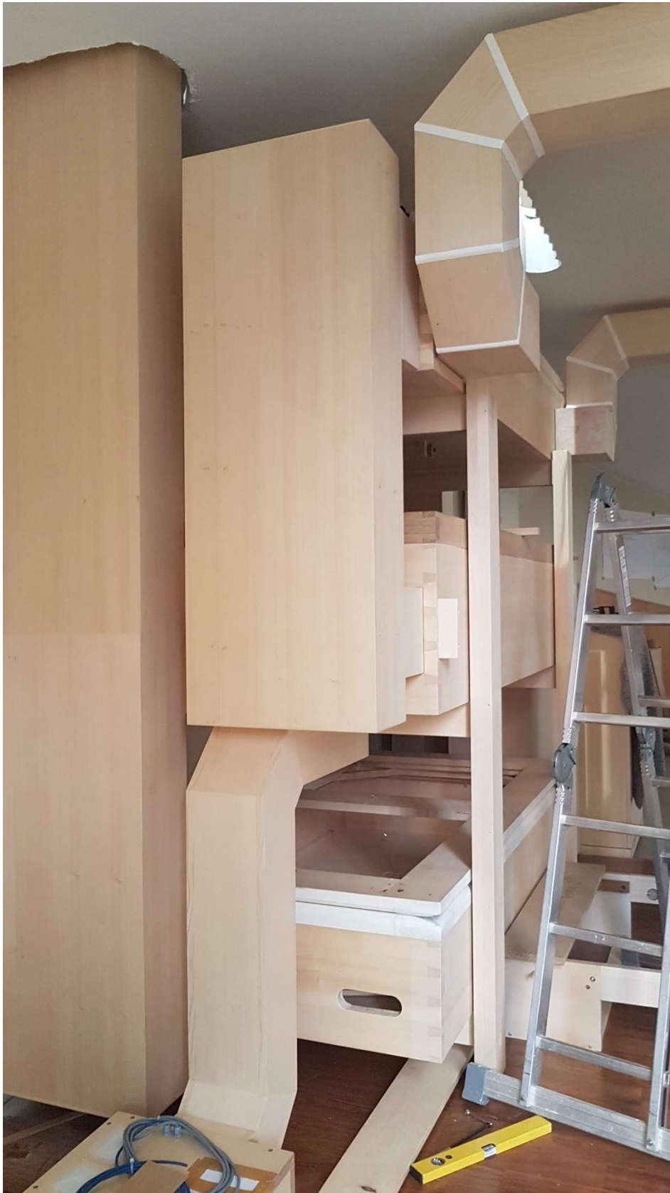
Windanlage während der Montage
